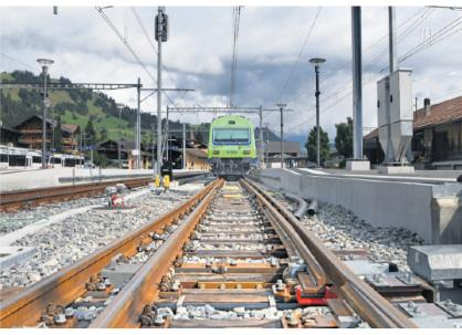
Von der Meterspur der MOB auf die Normalspur der BLS geht es ab Ende 2020 in Zweisimmen automatisch und vier Zugpaare rollen von Montreux für die Fahrgäste umsteigfrei nach Interlaken.
